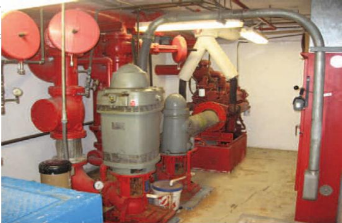
الشكل 7-10/4: مضخات إطفاء حريق فوق سقف خزان خرساني يقع تحت مستوى الارضية [9]
